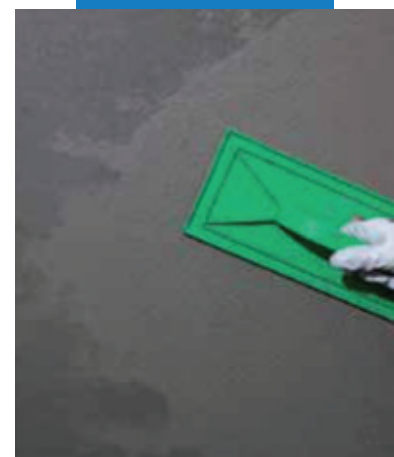
Заглаживание слоя MapregROUT 230 ( Мапеграут 230 )
