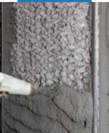
Нанесение Марегрут 230 ( Малеграут 230 ) набрызгом
