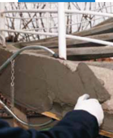
Нанесение Марегрут 230 ( Малеграут 230 ) при помощи мастерка
